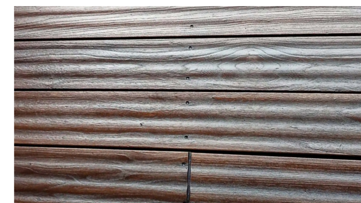
Восстановленная терраса из термосясы после обработки лаком DeckFinish цвет темно-коричневый.
