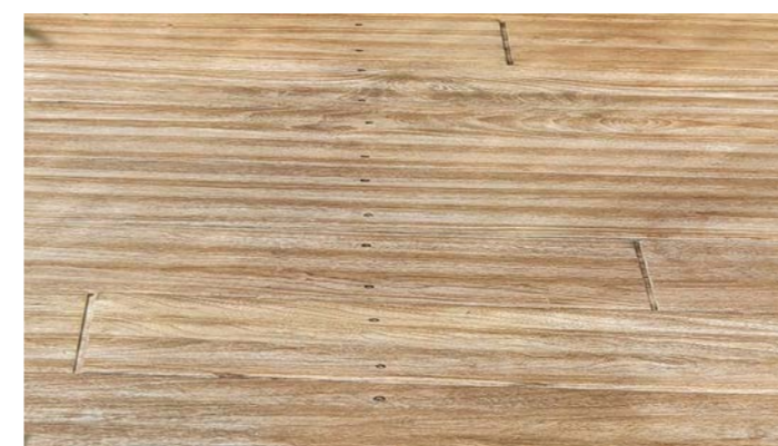
Старая терраса из термосясы после обработки средством от посерения DeckDegrauer.
