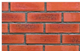
Кирпичный фасад после очистки
